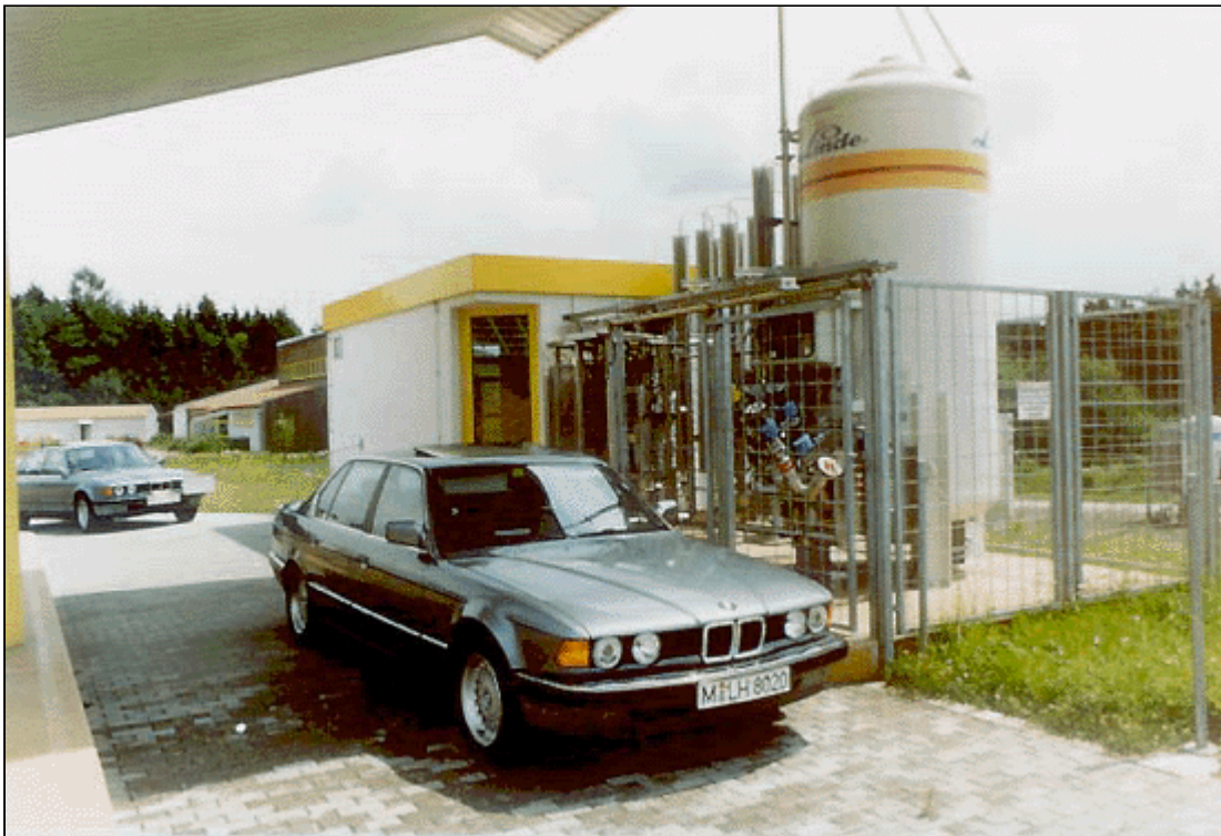
Abb. 7: Tankstelle für Flüssig-Wasserstoff
